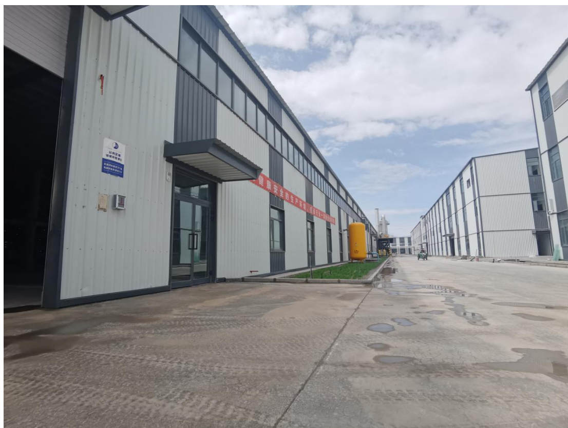
现场踏勘情况
